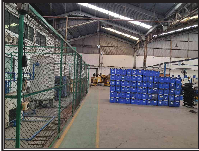
TAMPAK DALAM BANGUNAN PABRIK INTERIOR VIEW OF THE FACTORY BUILDING
